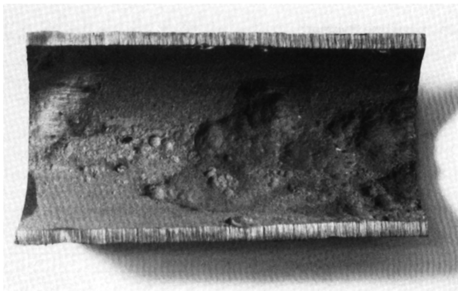
Ausgeprägte Mulden infolge Sauerstoffkorrosion in einem Rohr aus St 37 nach Entfernung der Korrosionsprodukte.
